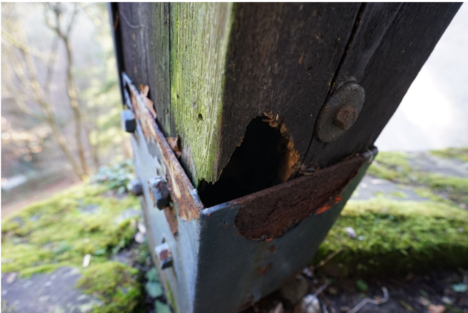
ABB. 34: DIE STÜTZE MIT DER MARKIERUNG 4 AN DER OSTFASSADE HAT DIE FORTGESCHRITTENSTEN SCHÄDEN UND BRINGT NUN AUCH STATISCHE PROBLEME MIT SICH (TIZIAN REIN 2021)
