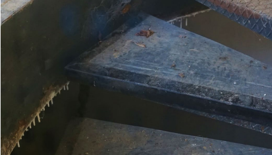
ABB. 35: AUCH IM INNEREN GEHEN DIE FEUCHTIGKEITSSCHÄDEN WEITER, ES WACHSEN STALAKTITEN (TIZIAN REIN 2021)
