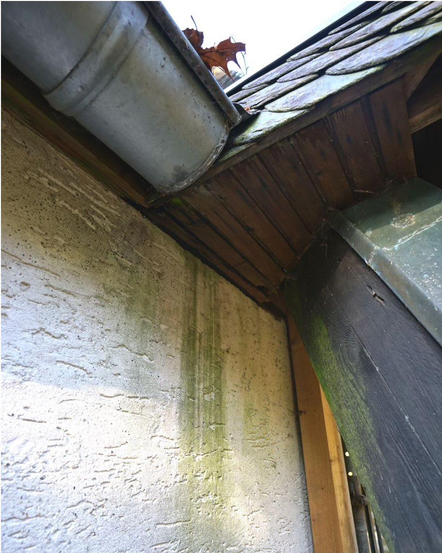
ABB. 32: VERFÄRBUNG DURCH ALGEN DEUTET AUF UNDICHTIGKEITEN HIN (TIZIAN REIN 2021)
