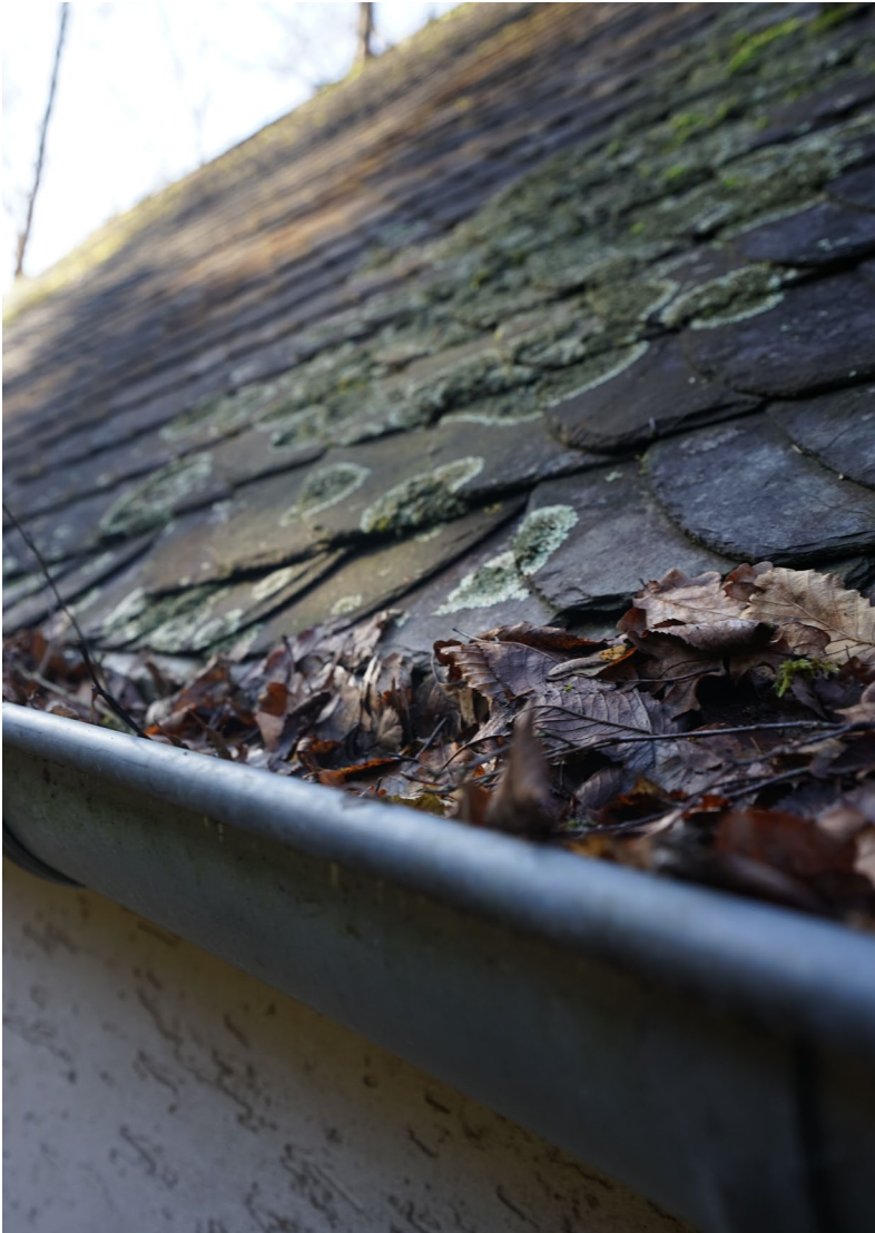
ABB. 33: DURCH DIE ÜBERFÜLLTEN UND UNGEREINIGTEN WASSERINNEN IST EIN ABFLUSS KAUM MÖGLICH (TIZIAN REIN 2021)
