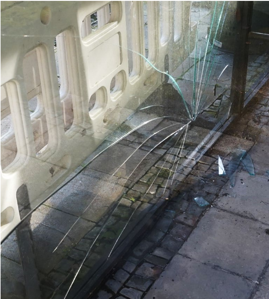
Abb. 37: Dieser Glasschaden entstand in jüngster Zeit (Tizian Rein 2021)
